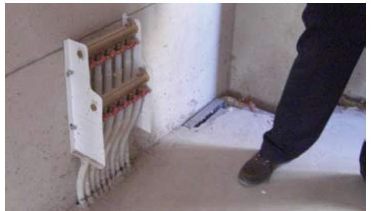
Fußbodenheizung in einer sich im Bau befindlichen Wohnung aus der 1. Phase
