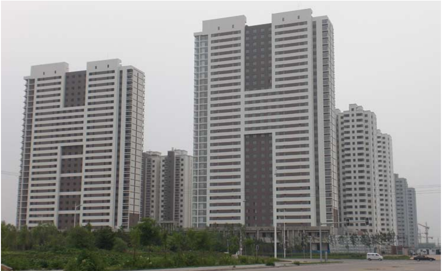
Bereits fertiggestellte Gebäude der 1. Phase (Bild: Sommer 2009)
