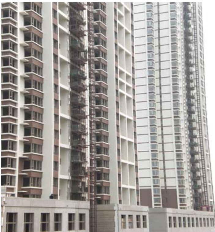
Die Baustelle der 1. Phase
